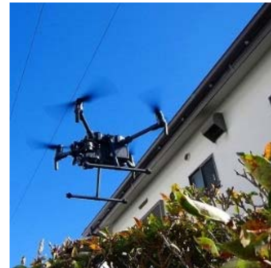
UAVsを活用した外壁点検業務
